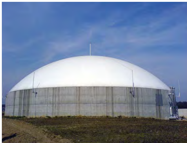
Figura 1. Depuratore di Landau (A)
