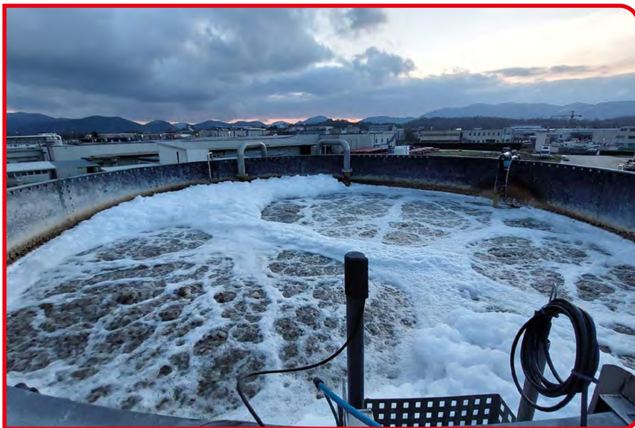
Impianto MBBR presso lo stabilimento di Carsoli di Madama Oliva
