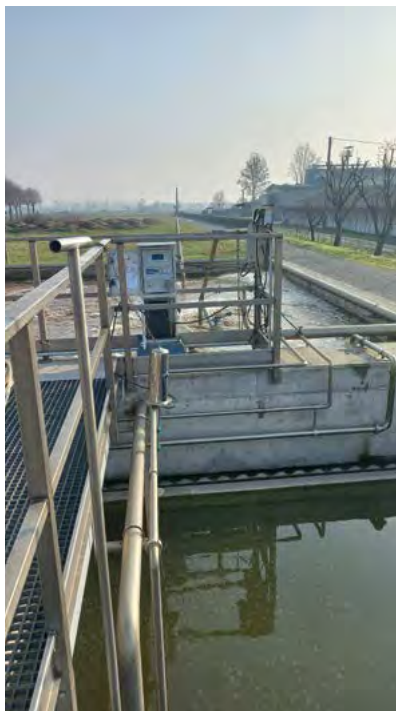
Impianto caseificio, sonda CODout in sedimentazione e Misuratore fanghi Vf30 al termine ossidazione.
