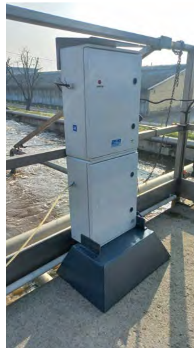
Impianto caseificio, sonda CODout in sedimentazione e Misuratore fanghi Vf30 al termine ossidazione.
