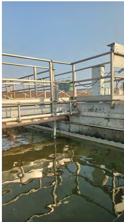
Impianto caseificio, sonda CODout in sedimentazione e Misuratore fanghi Vf30 al termine ossidazione.
