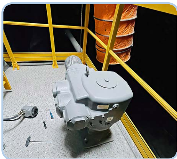
Figura 4. Attuatore multigiro SA-UW in fase di installazione in impianto.
