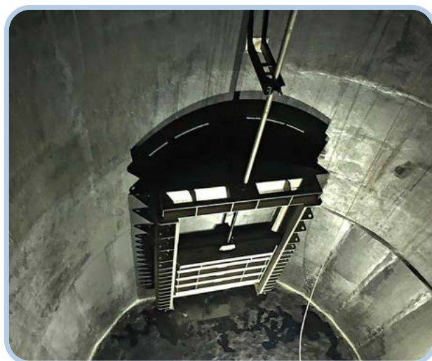
Figura 3. Dettaglio della camera sotterranea con saracinesca.
