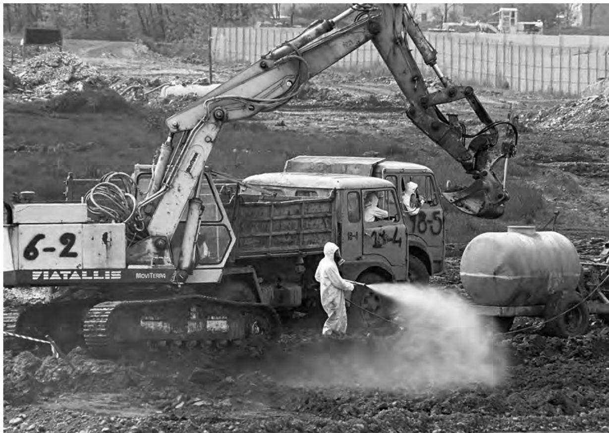
Figura 2 – Lavori di decontaminazione dell'area inquinata. Foto di Dino Fracchia © Dino Fracchia / buenaVista photos
