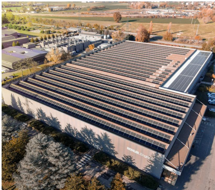
**Figura 1.** Pannelli solari per l'impianto targato Grastim per lo stabilimento di Kohler Engines a Reggio Emilia.
