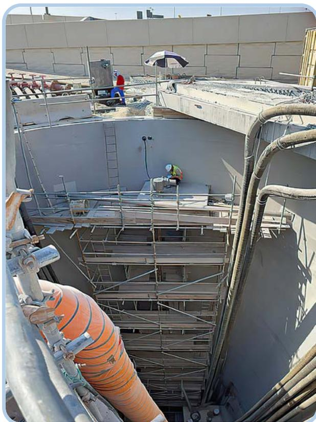
**Figura 2.** Posizionamento e verifica degli attuatori nella camera sotterranea per la raccolta delle acque.
