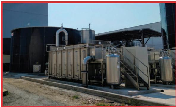
I flussi, segregati per tipologie produttive e carico di COD, sono trattati con dei flottatori dedicati IDRA-FLOT<sup>®</sup>, processo di flottazione ad aria disciolta per rimuovere oli e grassi dall'attività produttiva.
