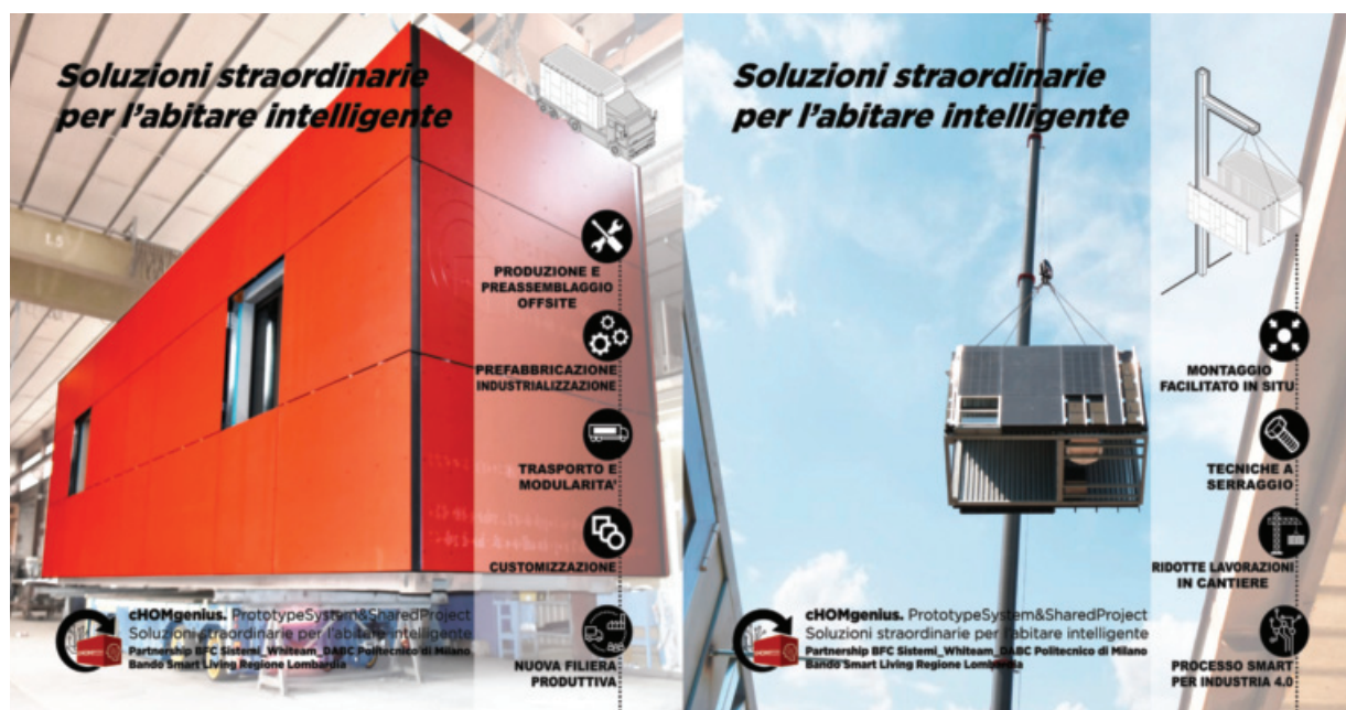
Figura 7 – Fasi di assemblaggio in officina e di installazione in situ
