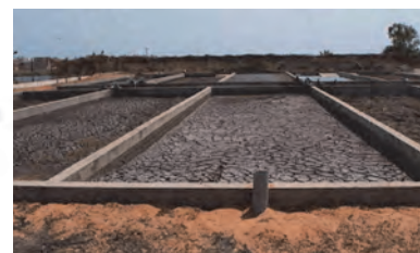
Figura 21 – Schema e foto di un tipico letto di essiccamento a sabbia (Andreoli et al., 2007)
